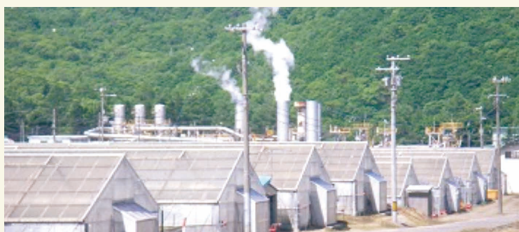
地熱水を利用したハウス
