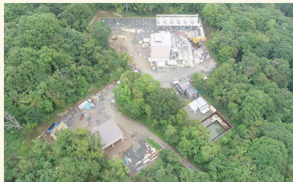
建設中の発電所(2020年9月中旬時点)
